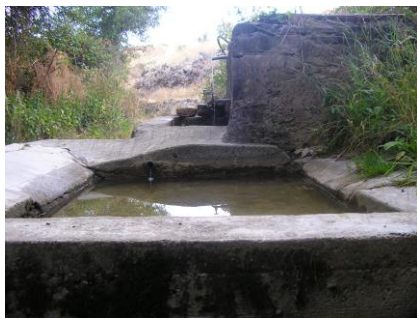
Fuente y lavaderos de El Pozo, construida en 1956
