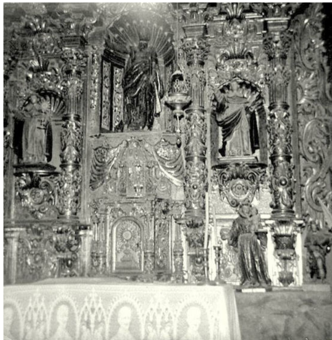
Retablo Mayor de la iglesia de Sarnago. Cuando el tejado colapsó quedó destrozado y "enterrado" debajo del escombros.
