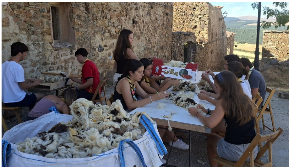
Los scouts clasifican y preparan la lana de oveja que servirá como aislamiento natural de El Refugio de Sarnago. Un trabajo artesanal que recupera un material tradicional para un proyecto de construcción sostenible.
